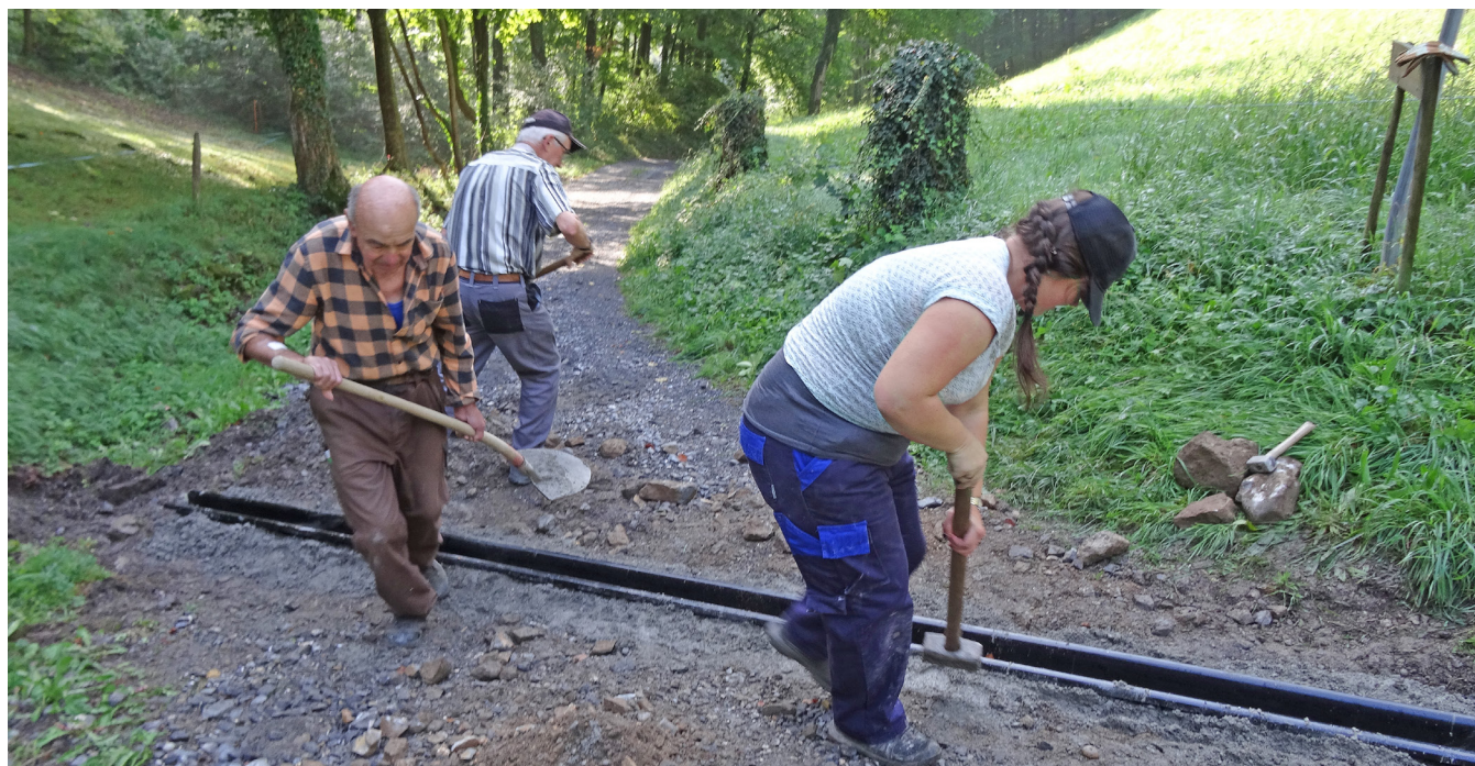
Arbeiten an der Stiegstrasse unter der Leitung von Wendelin
