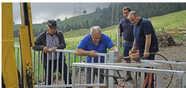
Präzisionsarbeit auf der Alp Loos, ein Eisengatter wurde installiert
