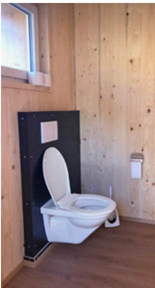
Auch ein modernes WC wurde in den Neubau integriert.
