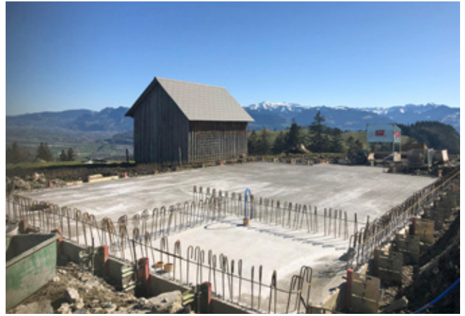
Die Bauarbeiten konnten leider nicht immer bei bestem Wetter ausgeführt werden.
