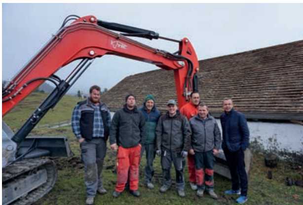
...und wartet auf die Abbruchmannschaft, welche vor der Arbeit noch für ein Erinnerungsfoto posiert.
