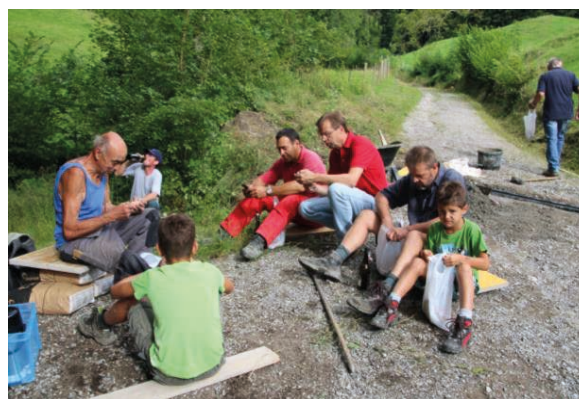
Harte Arbeit. Die Strassenbauer beim verdienten Znüni.
